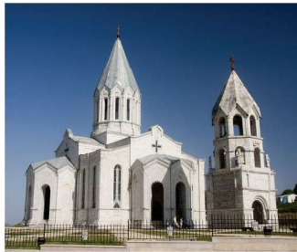
İşğal dövründə vandalizmə məruz qalmış vəziyyəti
